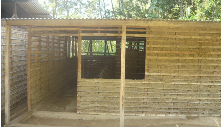
Bâtiment en construction de la boulangerie communautaire de San Isidro
